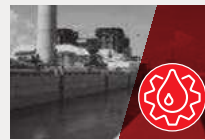
Trattamento delle acque Water treatment
