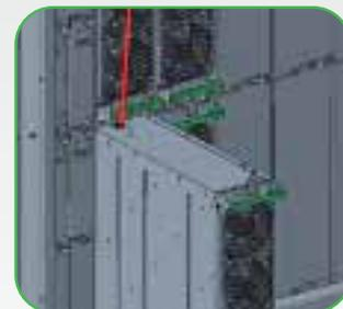
Spingere verso il basso il blocco del modulo di alimentazione e estrarre il modulo di alimentazione.
