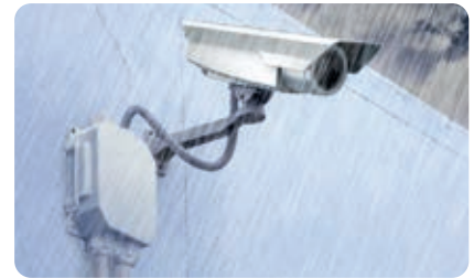
Installazione con cavi liberi.
