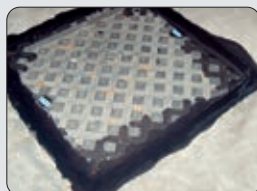
Sigillatura pozzetti
